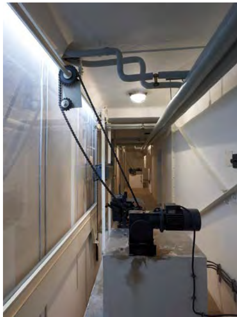
Dvě velká okna je dodnes možné pomocí elektromotorů spouštět až k podlaze. Na obrázku je příslušná strojovna.
