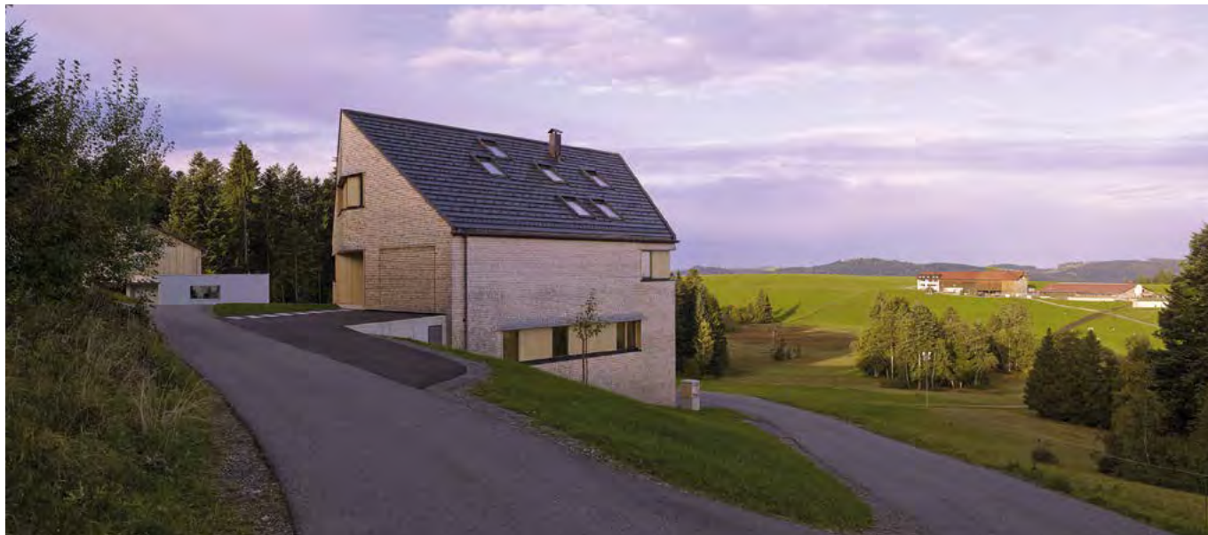
Původním záměrem byly dvě samostatné budovy. A tohle je konečný výsledek, se kterým je rodina velmi spokojena.
