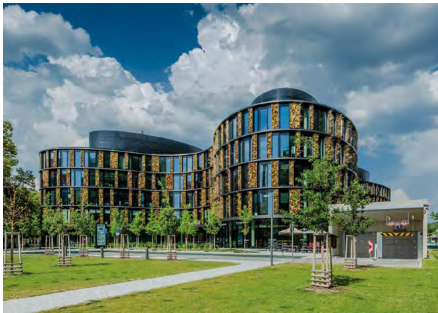
Jednou z budov, ve které bude technologie proti covidu nainstalována, je AFI Karlín.
