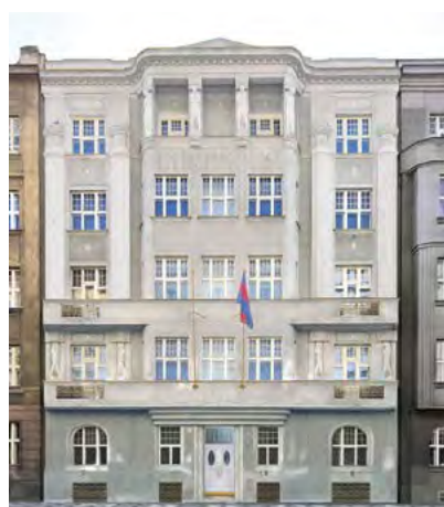
Plasticitu fasády bude nově zvýrazňovat citlivé podsvícení, dešťové svody budou kompletně provedeny z mědi.
