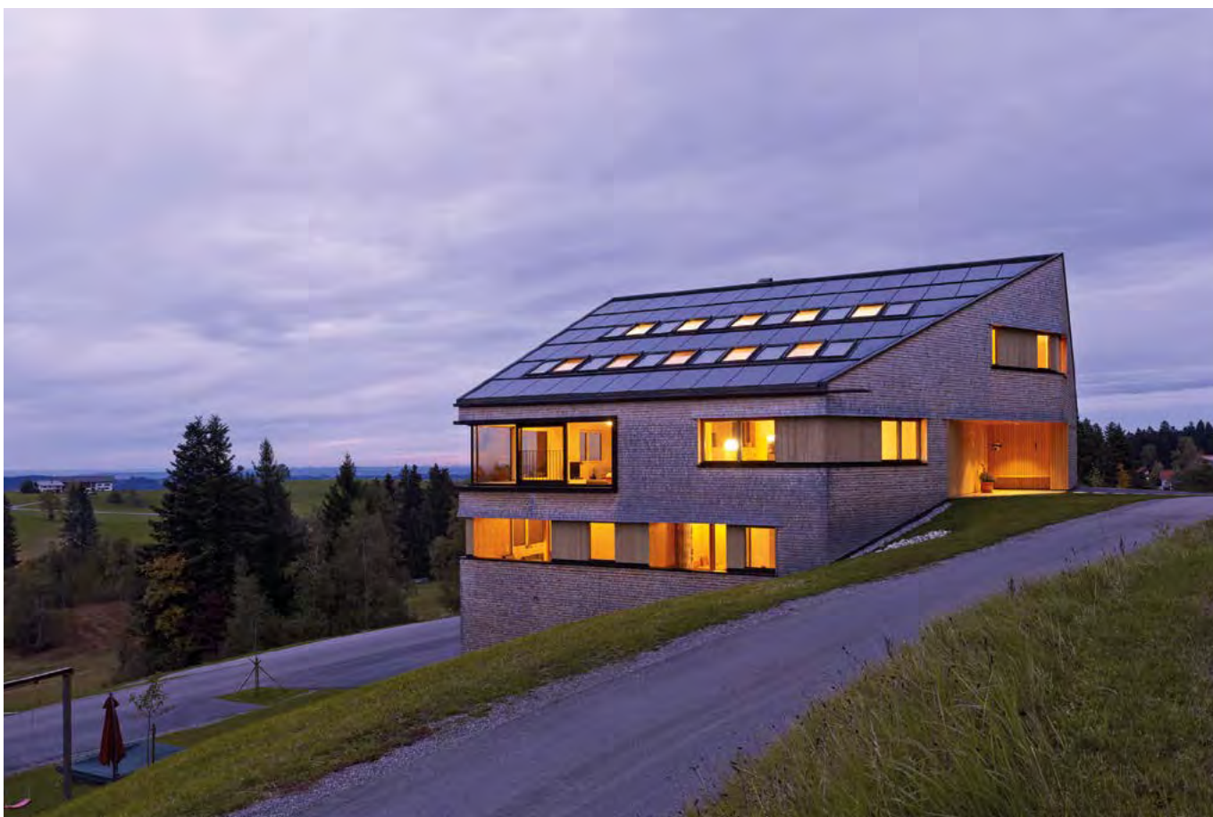
Dům si díky solárním panelům vyrobí sám dostatek elektřiny. V létě má dokonce nadprodukcí.
