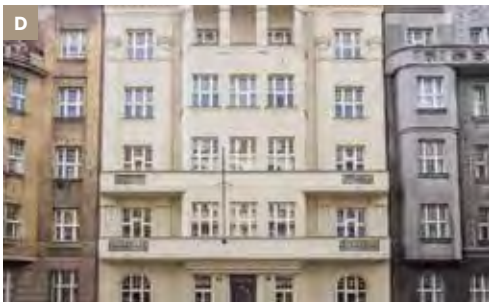
D Praha 6 – Bubeneč Rezidence architekta Petráka
