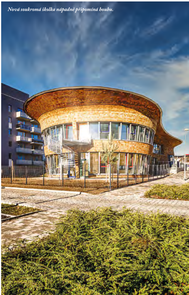
Fasáda je z dřevěných šindelů z červeného cedru.
